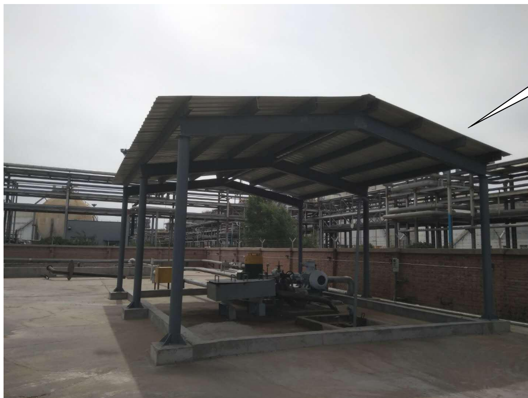
卸油区防雨棚
